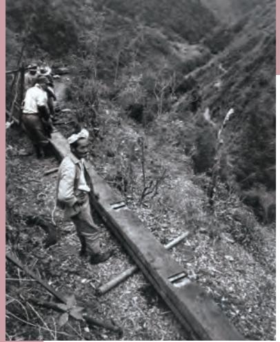
宇留志では家屋を移転先に移築した例があった。その作業は、大小の部材を谷に渡したワイヤーロープを使って吊り下ろすというもので、急斜面での作業は慎重を要した。
