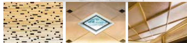
도사 편백나무 벽 [1층·2층·3층] 도사 도검류의 장식이 꾸며진 도사 회반죽 벽 [1층 로비] 도사 화지 천정 [1층 일본식 방]
